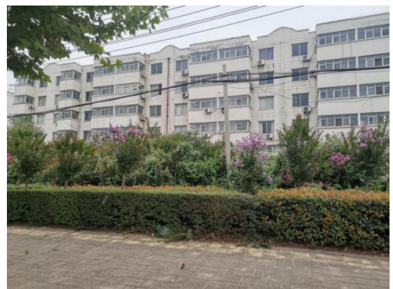
钢厂宿舍办公区
